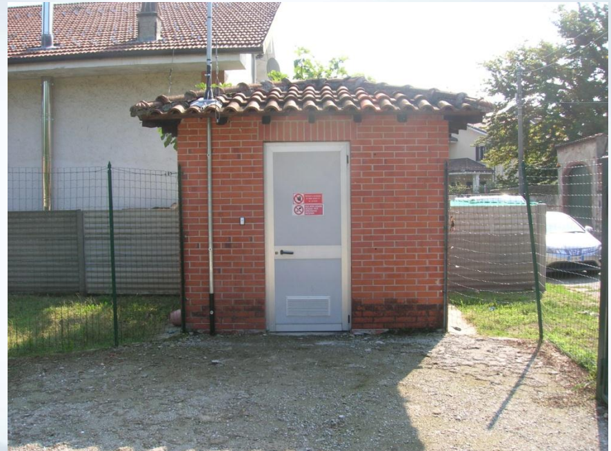
Stazione di Pompaggio
