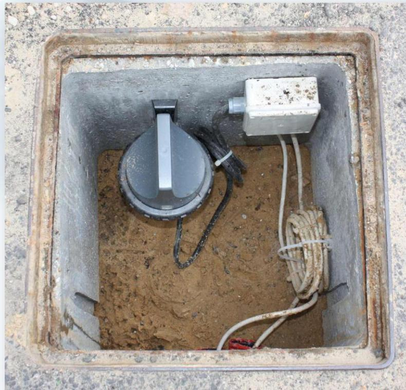
Esempio d'installazione del trasmettitore con collegamento al contatore tramite lanciaimpulsi reed e un sensore di pressione 4-20 mA
