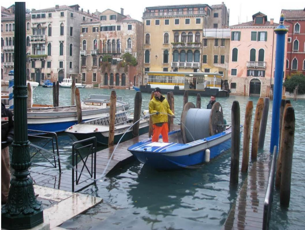
*Fig. 3. Installazioni cavo in fibra ottica a Venezia [VE]*
