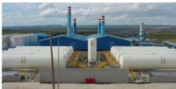
Sistema di **rigassificazione** (ad acqua glicolata o atmosferici). Il gas naturale, per poter essere utilizzato, deve essere sia gassificato (e' stoccato liquido) sia riscaldato (e' stoccato a  $\approx -150^{\circ}\text{C}$ )
