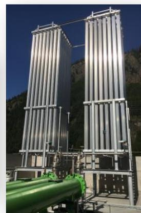
Sistema di **odorizzazione** e regolazione della pressione di utilizzo del gas naturale
