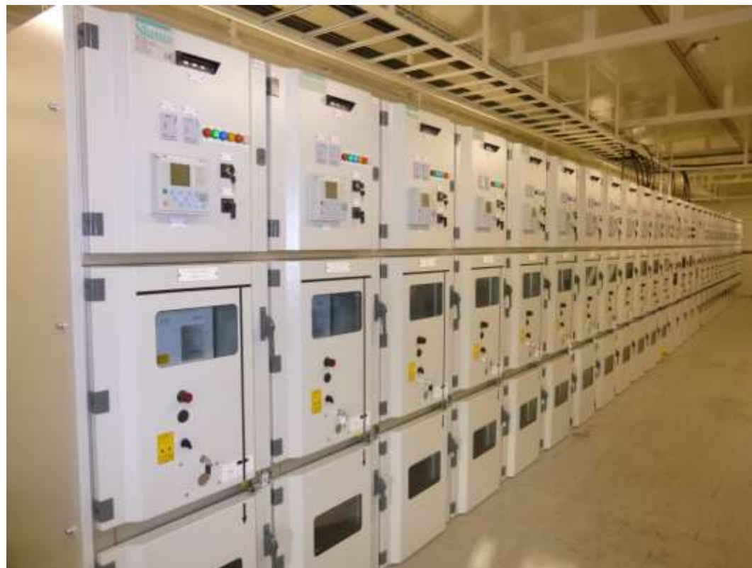
6.6 kV - 1.250 A (arco interno) 9 REF 630 - 59 REF 615
