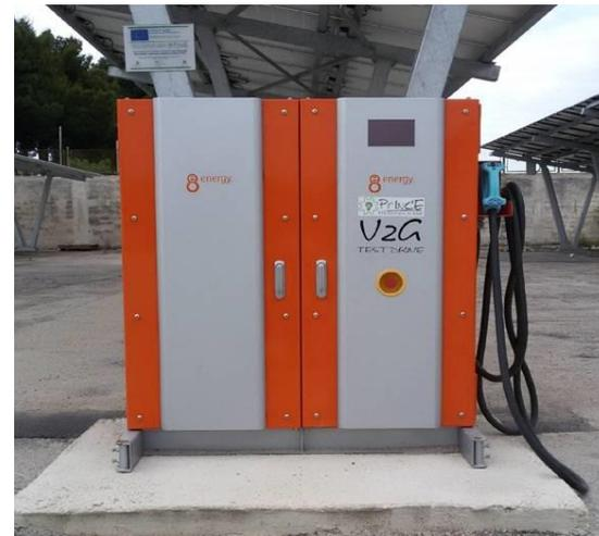
La colonnina in c.c. è connessa alla  $\mu$ G attraverso un convertitore bidirezionale che consente lo scambio bidirezionale di energia fra il sistema di accumulo a bordo dei veicoli e la microrete.
