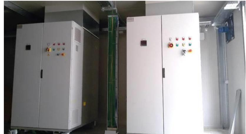
➔ I parametri dei due carichi RLC possono essere modificati sia attraverso un controllore locale (un PLC a bordo macchina) sia da SCADA.
