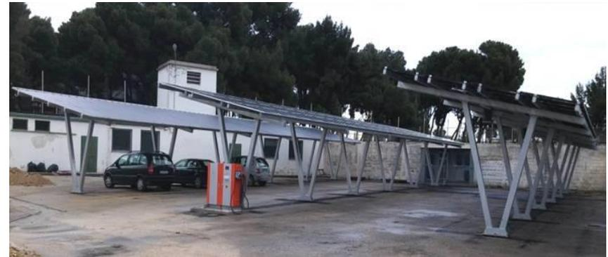
⇒ I moduli fotovoltaici sono stati posizionati su n. 3 pensiline ad ombreggiamento di parte dei parcheggi di un'area del campus del Politecnico di Bari, secondo una tipologia installativa di tipo fisso.
