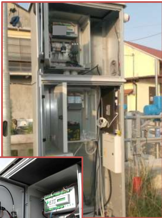
Impianti di telecontrollo
