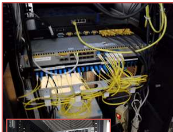
Centro di controllo – Router e media-converter
