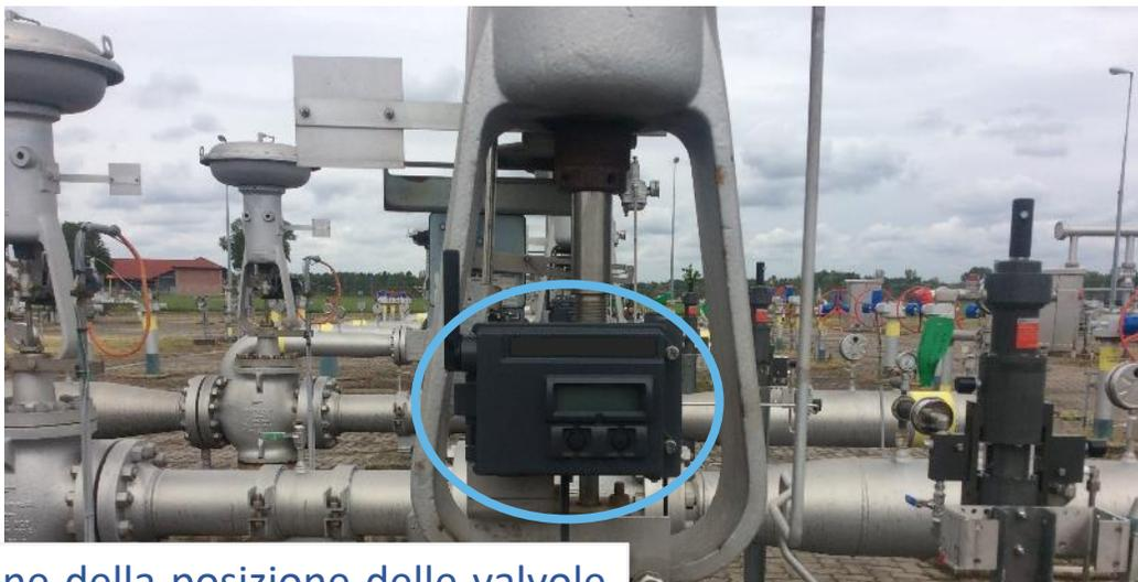
Rilevazione della posizione delle valvole monitor attraverso posizionatore smart
