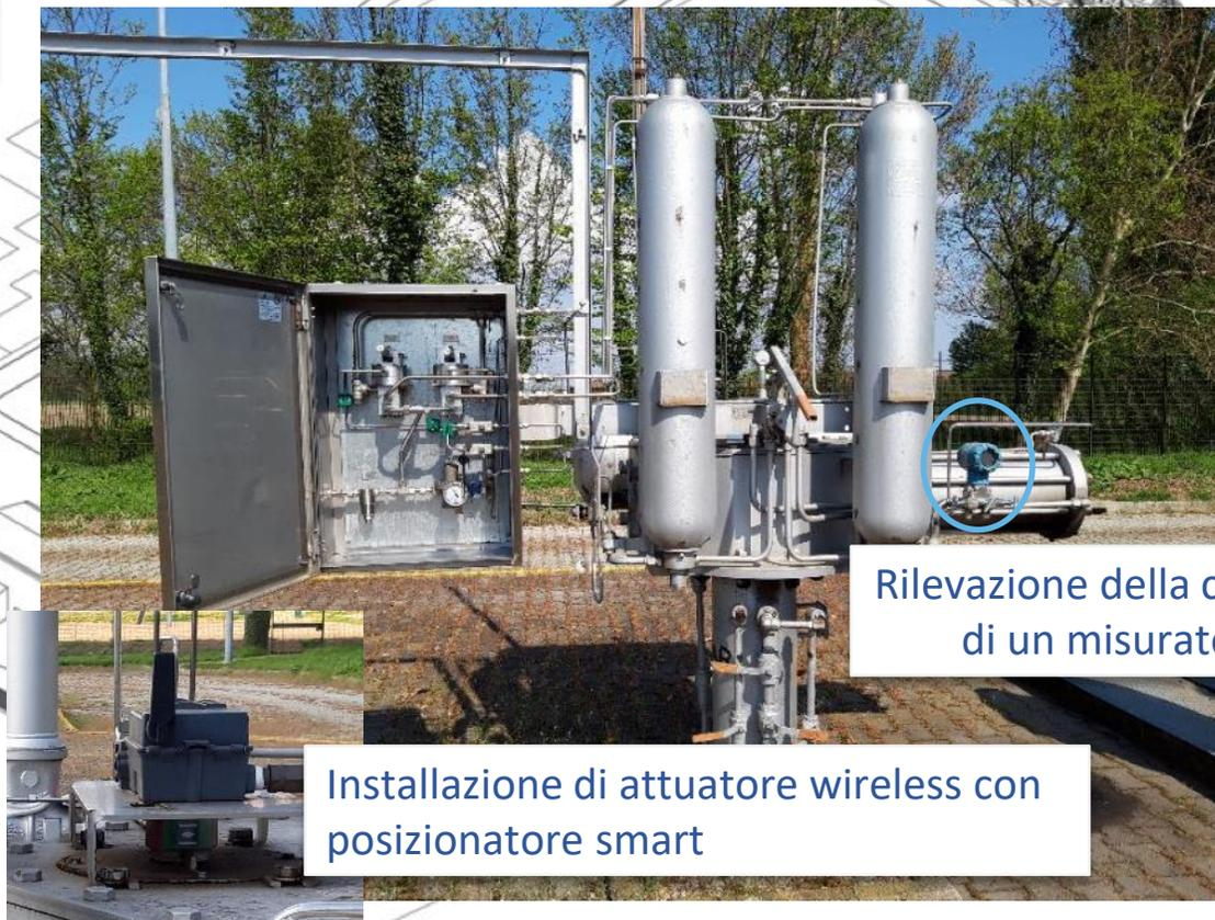
Rilevazione della coppia attraverso l'utilizzo di un misuratore di deltaP dell'olio
