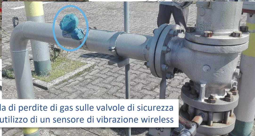
Rilevazione della di perdite di gas sulle valvole di sicurezza attraverso l'utilizzo di un sensore di vibrazione wireless
