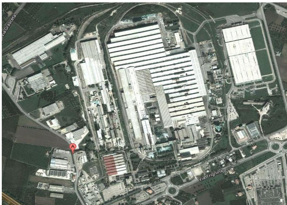
Stabilimento Pilkington di San Salvo
