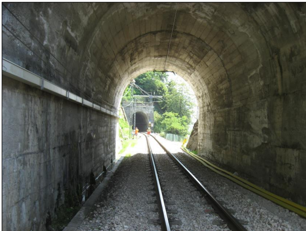
LAVORI IN GALLERIA
