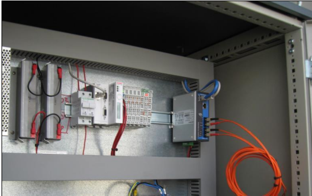
PLC INSTALLATO ALL'INTERNO DI UN QUADRO FERROVIARIO
